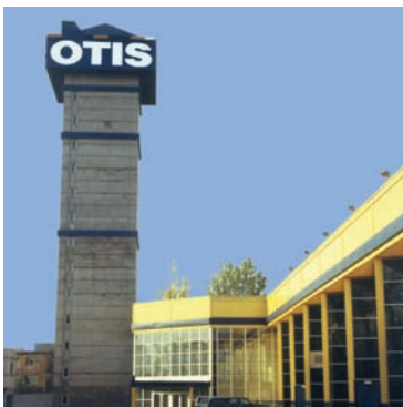
Завод по производству лифтов, Санкт-Петербург
